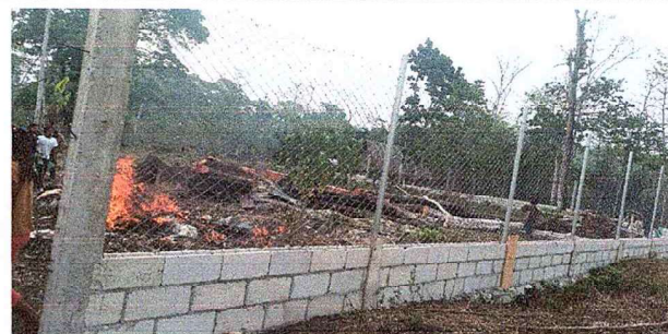
Foto 4: Finalización del muro de contención del predio escolar.
