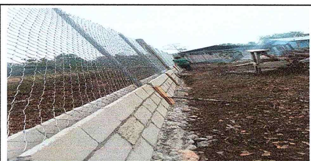
Foto 3: Finalización de muro de contención.
