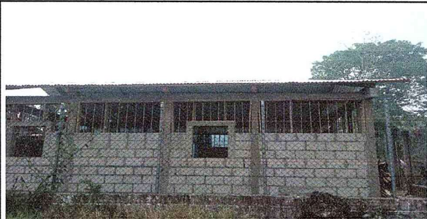
Foto 1: Finalización de cocina.
